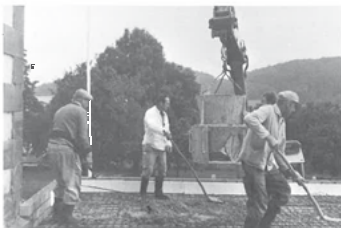
Vorbereitung zum Drahtbürsten
